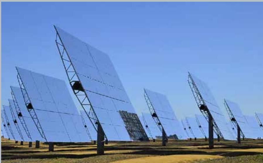
их необходимо регулярно очищать от пыли, иначе выработка электроэнергии уменьшится. Для этого Асте сначала использовала разбрызгиватели на тракторах, которыми управляли подрядчики. Но в 2019 году компания стала применять специальных роботов.
